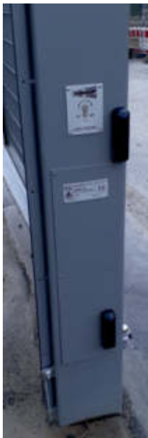
Steuerung im Pfosten integriert
